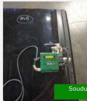
Soudure du profilé de raccordement sur la géomembrane
