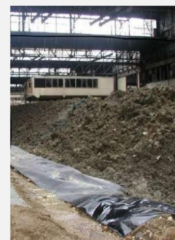
Les géofilms monocouche sont **étanches à l'air et à l'eau** et présentent une **opacité optimale** et sont traités au noir de carbone pour **résister aux UV**.
