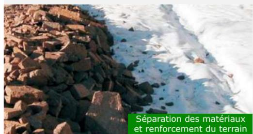
Séparation des matériaux et renforcement du terrain
