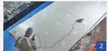
Avec une fraiseuse, les crampons sont retirés des emplacements des points fixes.
