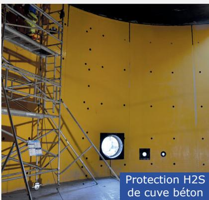
Protection H2S de cuve béton
