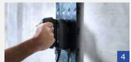
Les rondelles Induktofix sont soudées au moyen de la soudeuse à induction avec les plaques de protection AGRU PE-HD Ultra-Grip.
