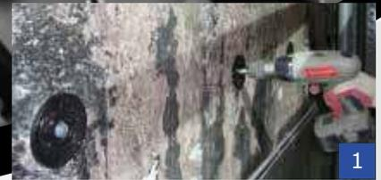
Pour le montage du revêtement, les rondelles de soudage Induktofix sont fixées mécaniquement, sans prénettoyage couteux.
