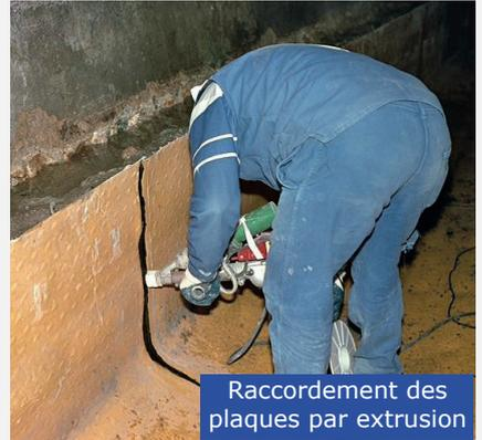
Raccordement des plaques par extrusion
